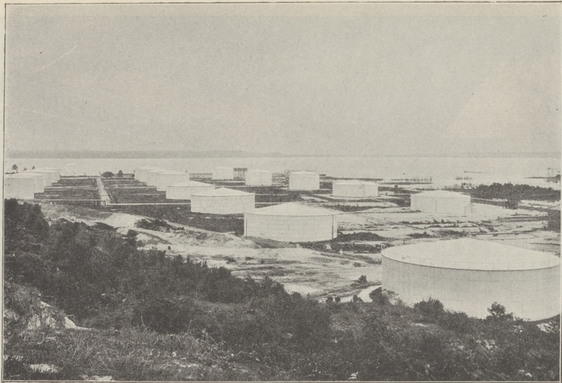
Tankinstallatie te Balikpapan.
