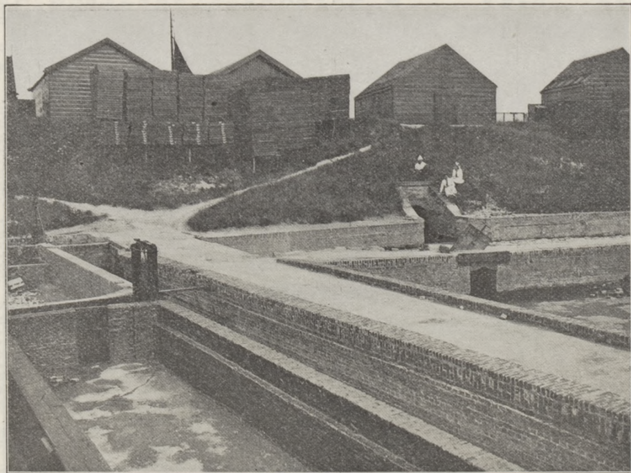
Binnenputten der oesterkwekerij te Ierseke.
