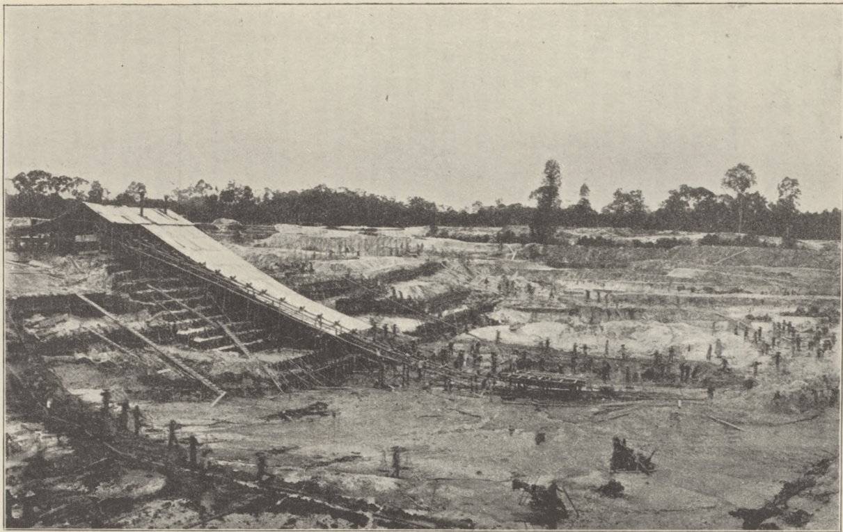
Transport van den bovengrond in de Bangka-tinmijnen.
